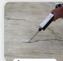
พื้นผิวถนนคอนกรีต Concrete road surface
