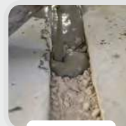
งานซ่อมร่องซ่อมบำรุง Repair grooving work
